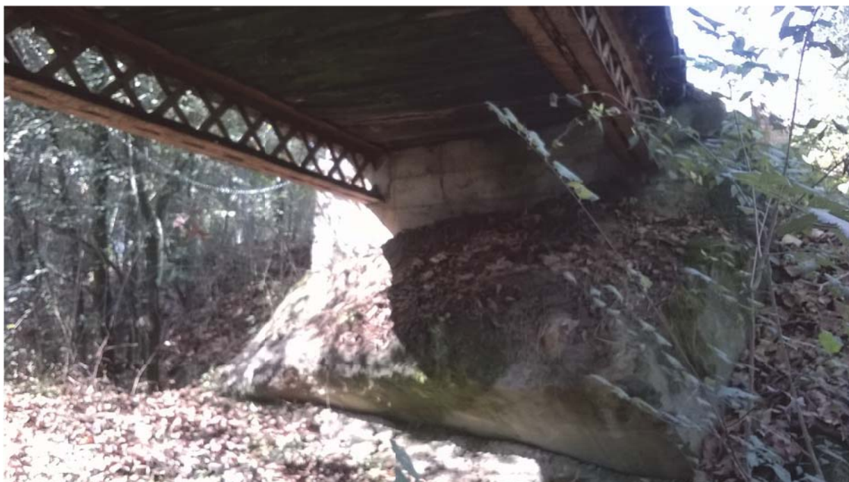
Foto 5. Vista inferior del Pont.
