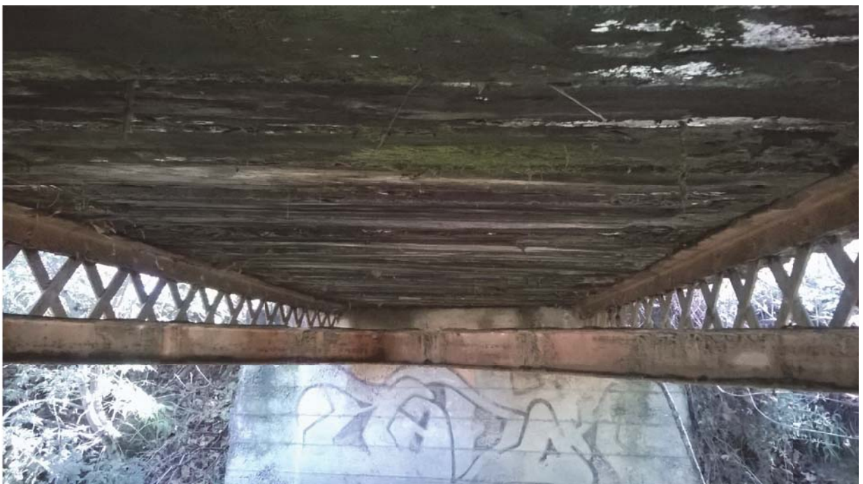
Foto 14. Vista inferior del Pont.
