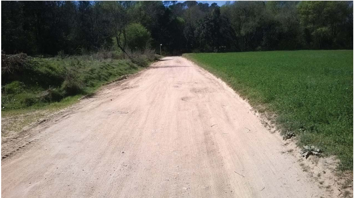
Foto 17. Camí de la Tordera entre pont Fuirosos i pont AP-7.
