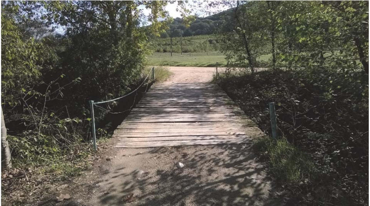
Foto 1. Vista general del Pont de Fuirosos.
