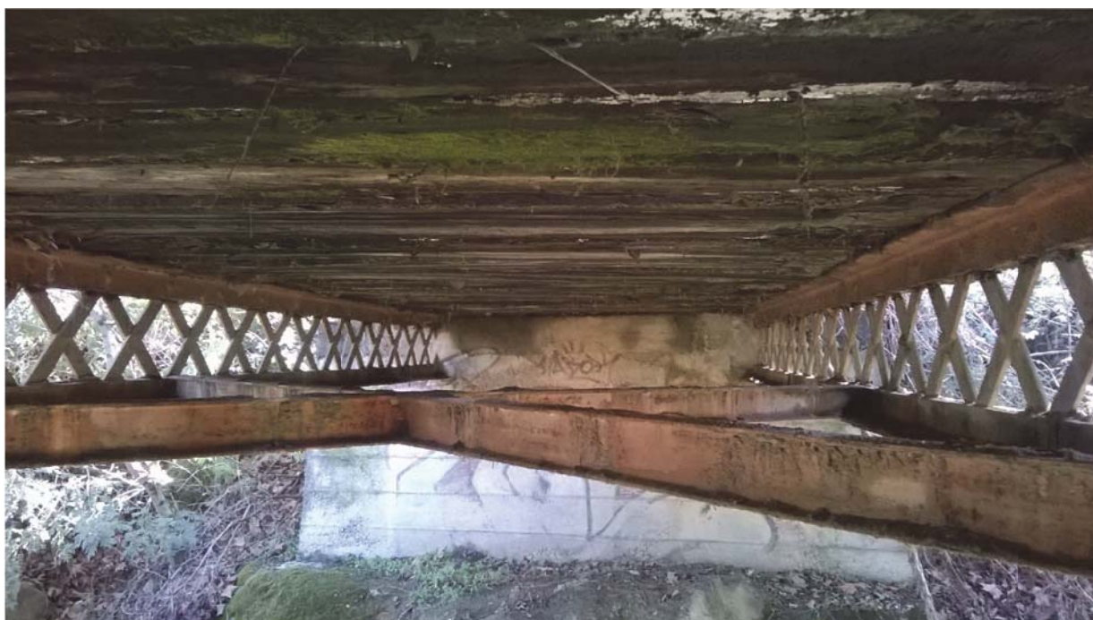
Foto 16. Vista inferior del Pont.
