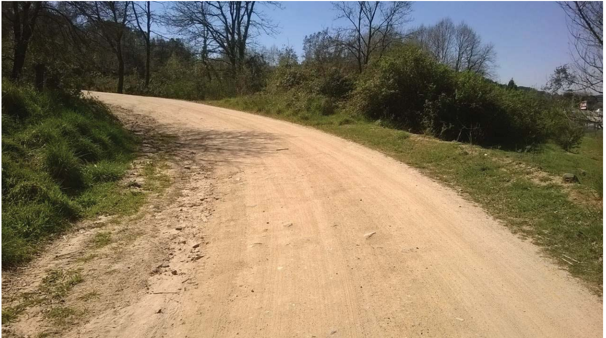
Foto 15. Camí de la Tordera entre pont Fuirosos i pont AP-7.
