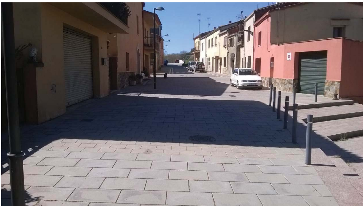
Foto 55. Tram de camí abans del pont Trencat.
