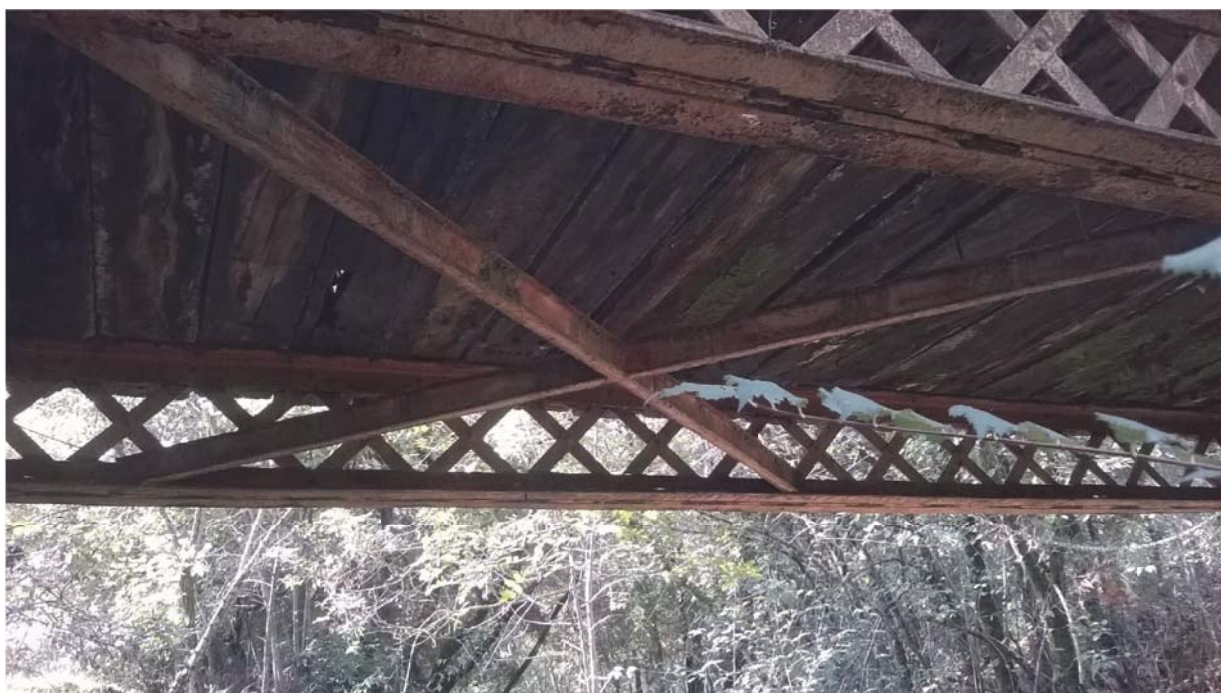
Foto 6. Vista inferior del Pont.
