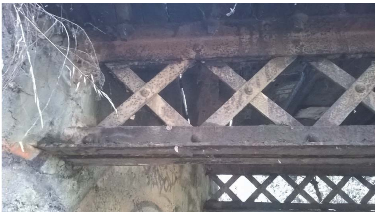
Foto 8. Vista de detall del Pont.
