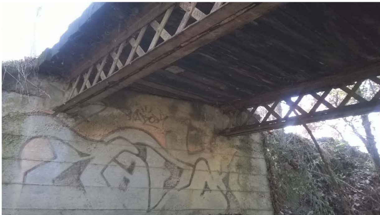
Foto 3. Vista inferior del Pont.
