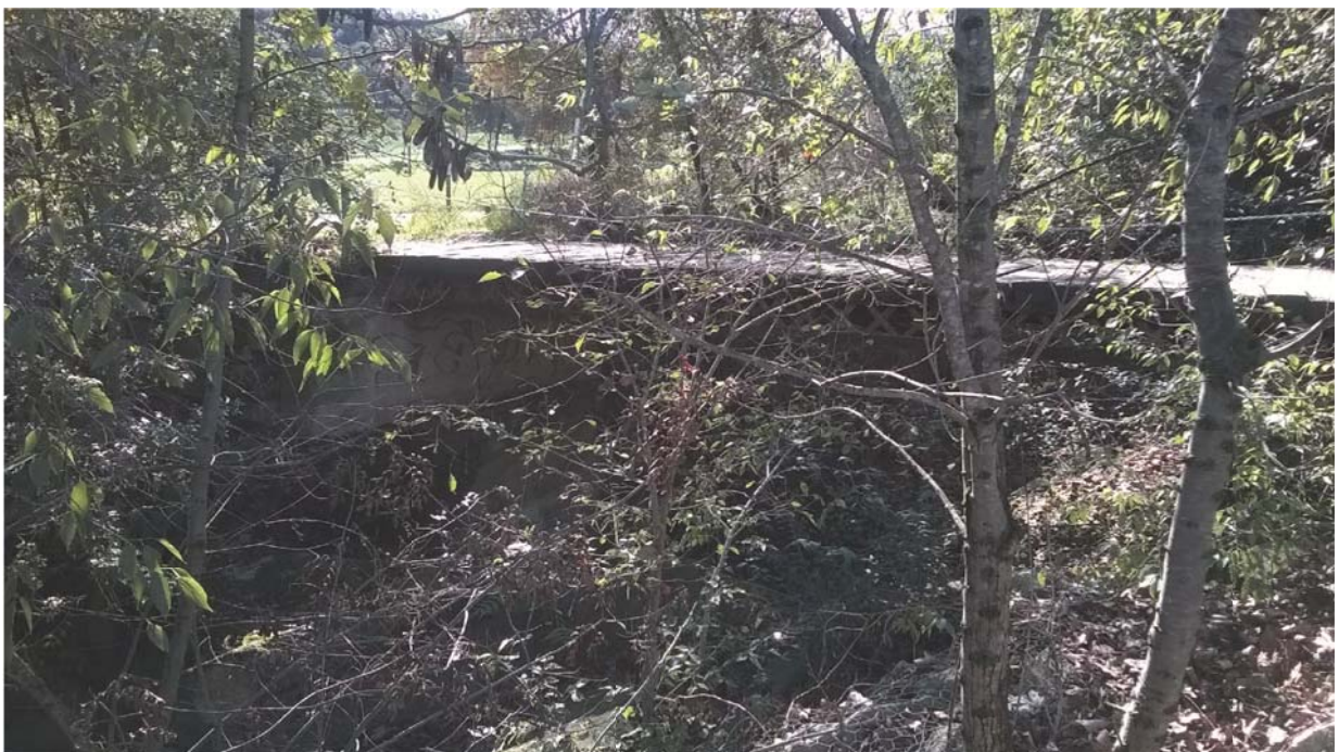
Foto 2. Vista lateral del Pont de Fuirosos.
