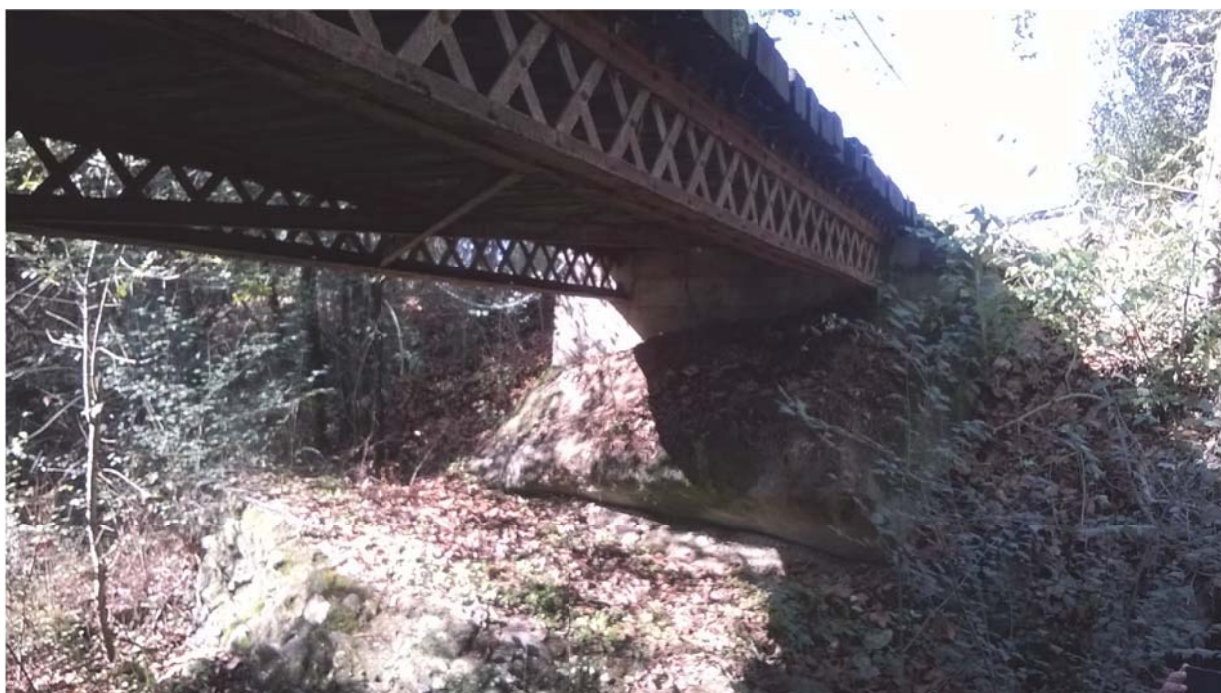
Foto 10. Vista inferior del Pont.
