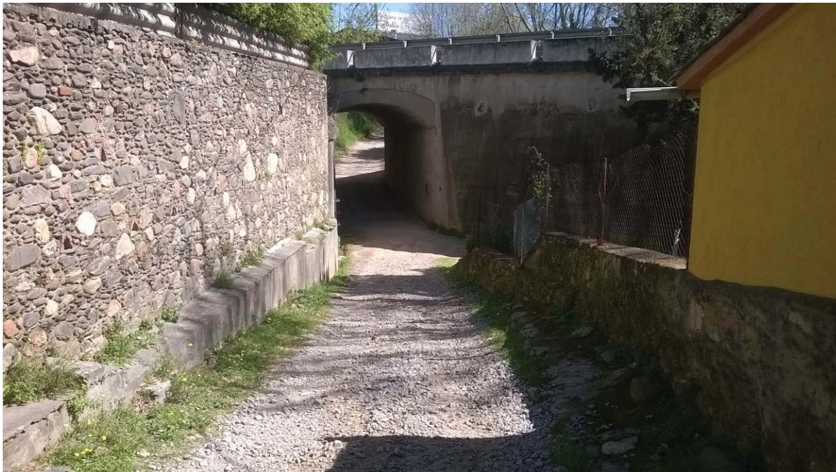
Situació actual del gual existent al vessant mar.
