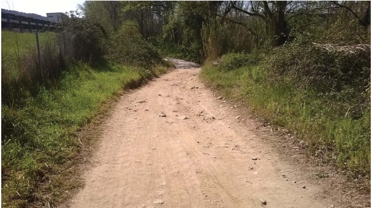
Foto 35. Tram de camí abans del pas de riera de Bocs.
