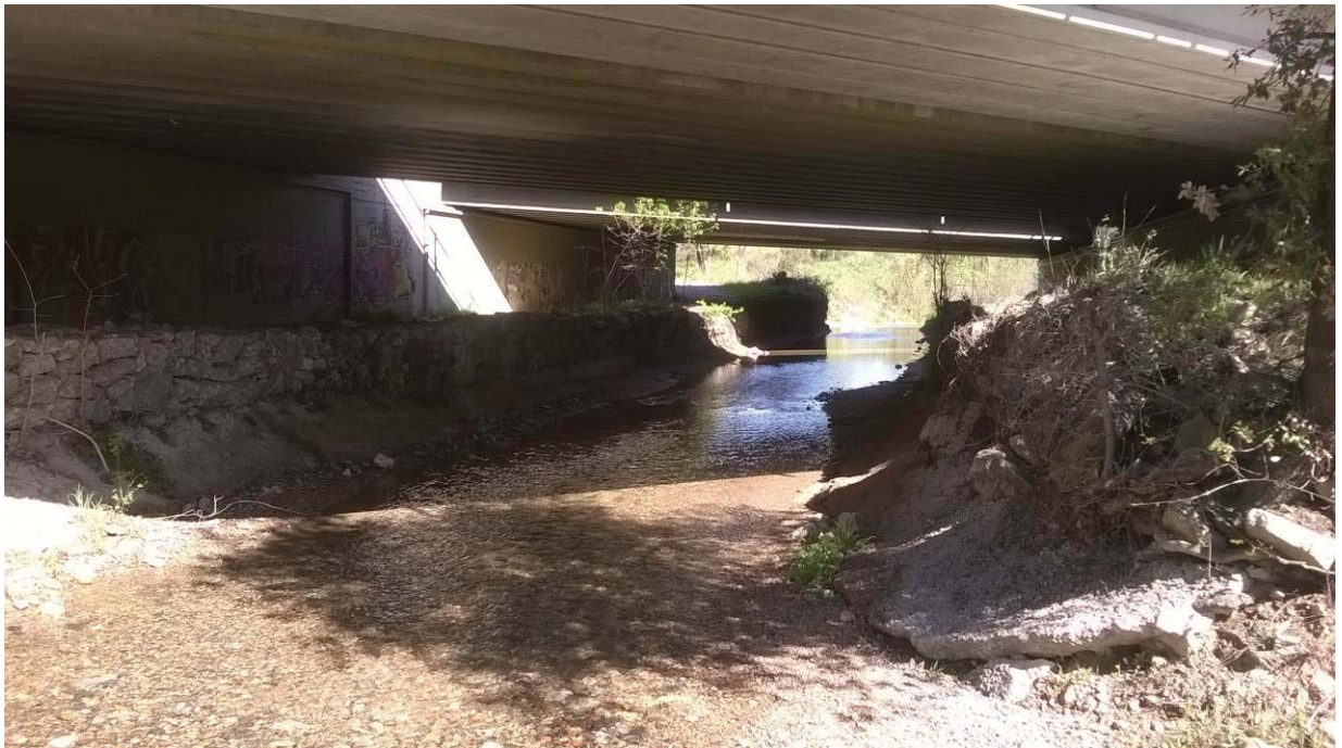
Foto 14. Riera de Fuirosos sota Autopista.
