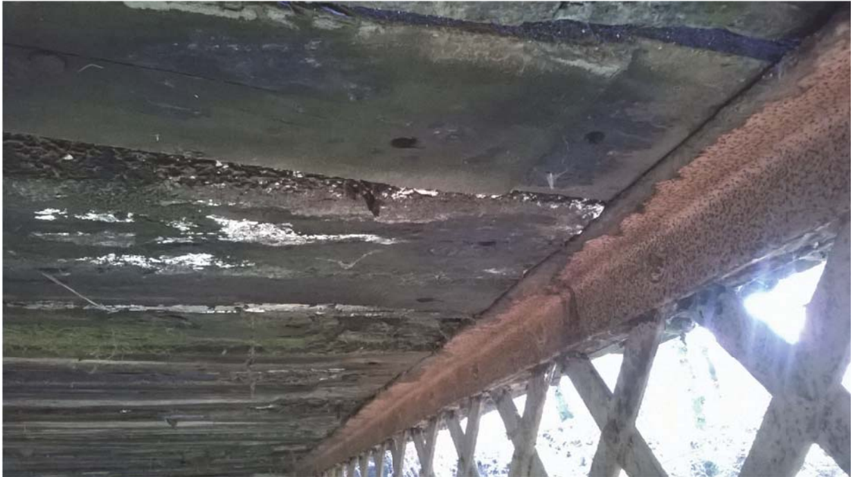
Foto 17. Vista inferior del Pont.
