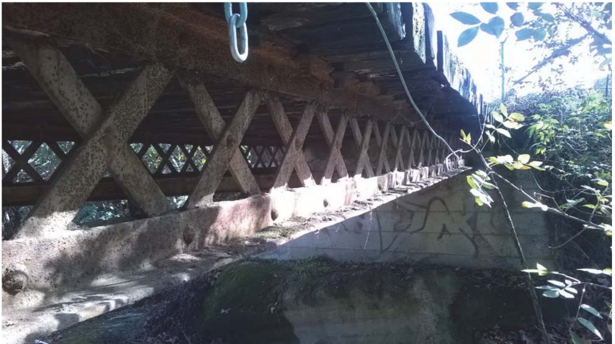
Foto 13. Vista de detall del Pont.
