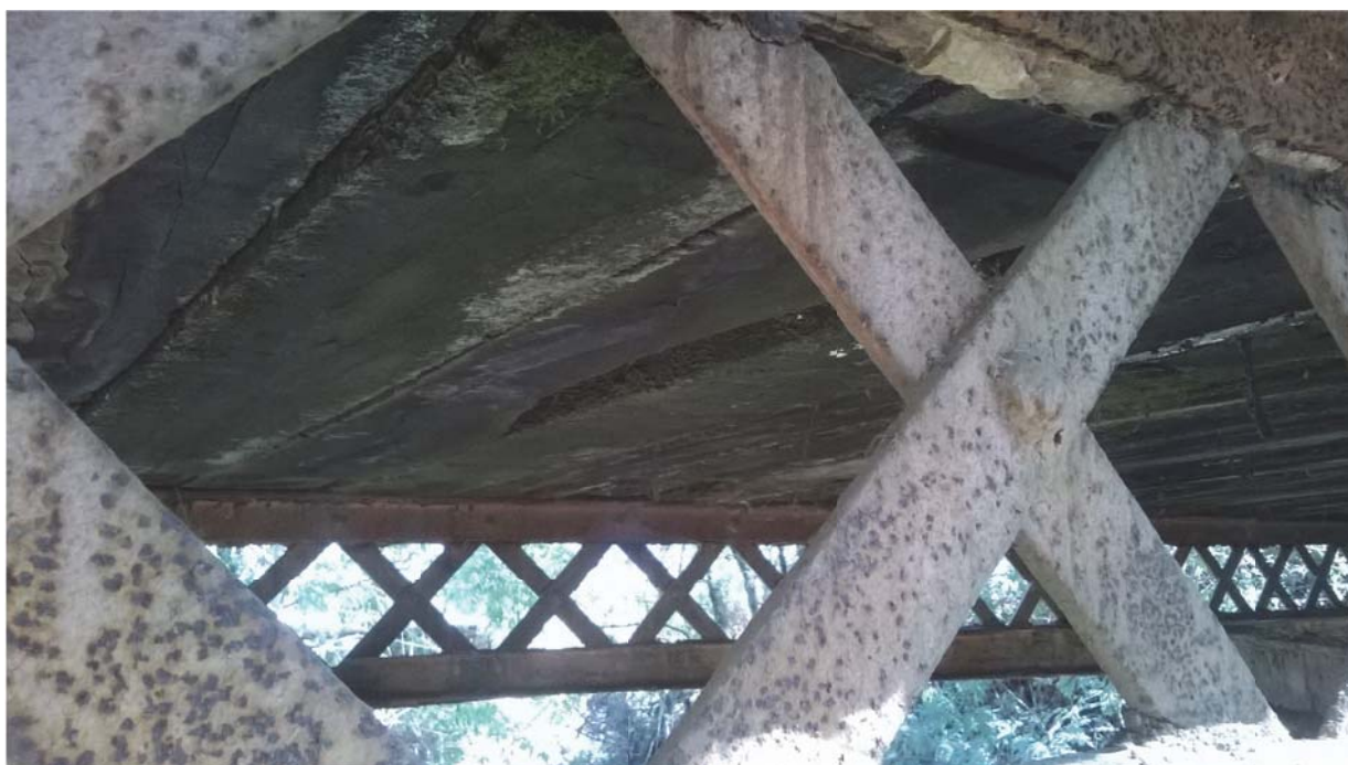
Foto 12. Vista de detall del Pont.
