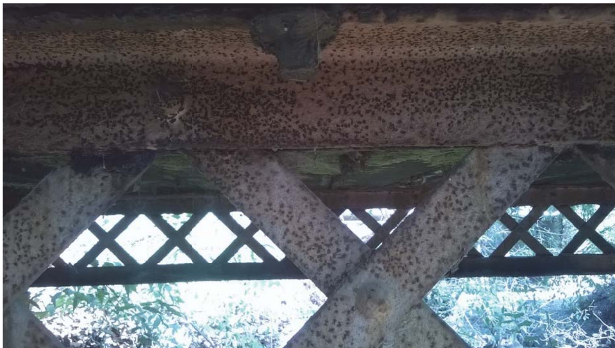
Foto 11. Vista de detall del Pont.
