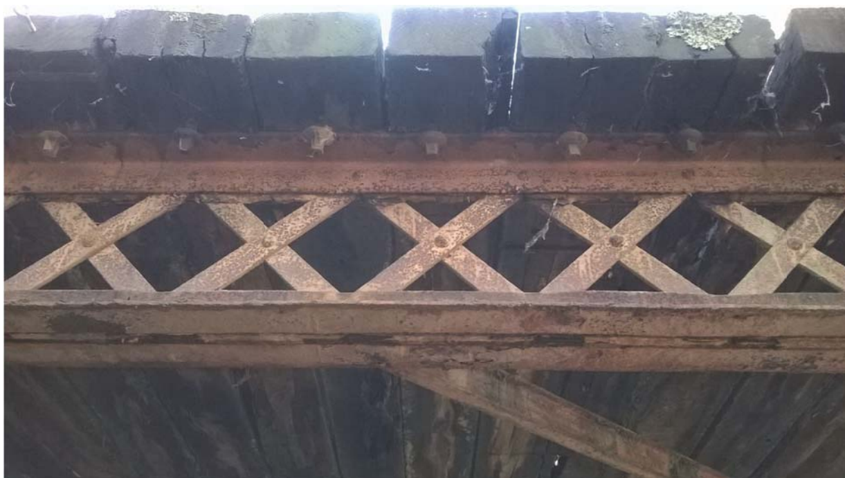
Foto 4. Vista de detall de l'estructura metàl·lica del Pont.
