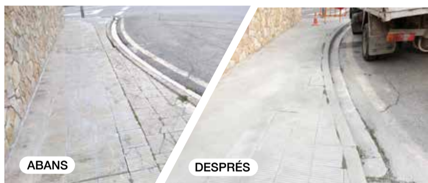
Reposició del paviment al carrer de la Diputació
