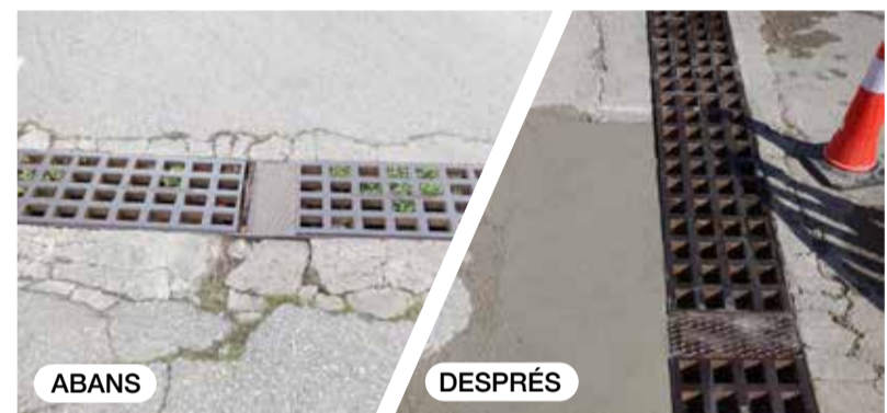
Reposició de perímetre de l'embornal al carrer de València
