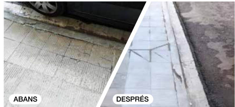
Reposició puntual de paviment al carrer de Barcelona
