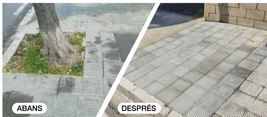
Ampliació d'escocell i reposició de paviment al carrer de Campins
