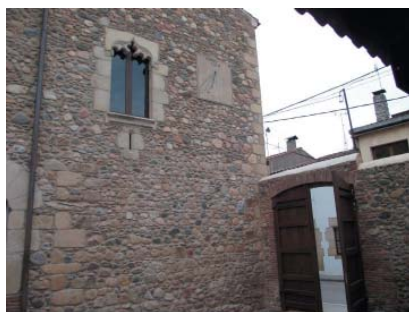
Façana interior de Can Bruguera
