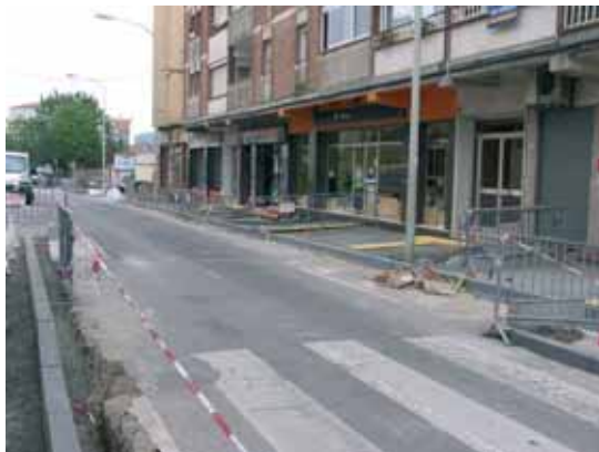
S'han reprès les obres a l'Avinguda de la Pau i s'hi han incorporat noves millores.
