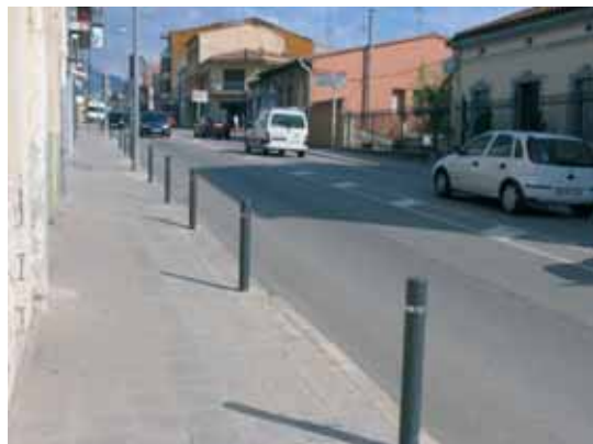
Les pilones de protecció garanteixen la seguretat dels vianants.
