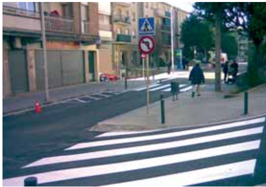
La intervenció ha millorat l'accessibilitat i seguretat de carrer
