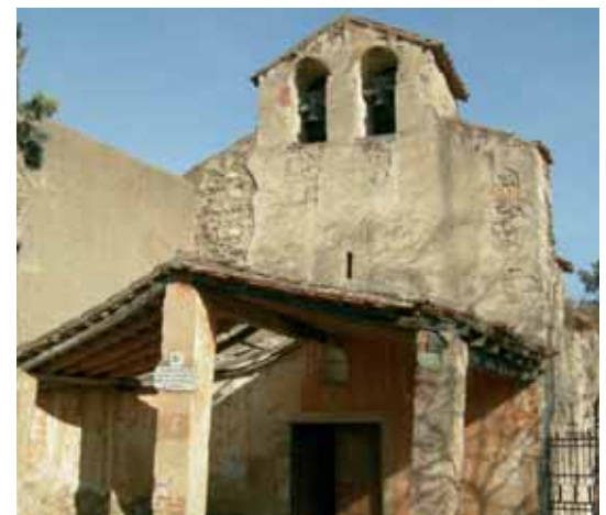
El projecte preveu arreglar l'estructura de l'edifici i tractar els paviments i paraments interiors i exteriors
