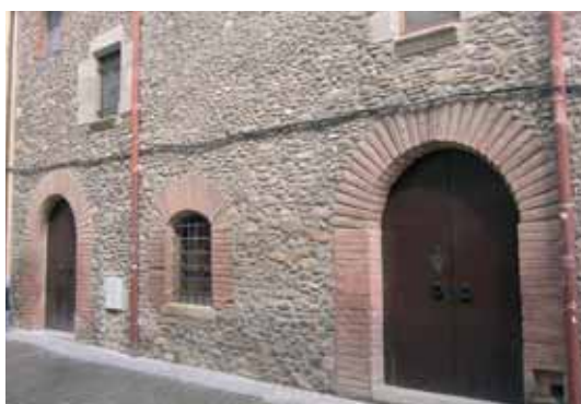
A l'entrada del carrer Major s'hi instal·larà una porta automàtica
