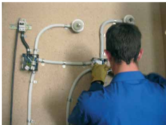
Els alumnes d'Auxiliar en muntatge d'instal·lacions elèctriques, d'aigua i gas realitzaran les pràctiques en empreses d'aquest sector i telecomunicacions.
