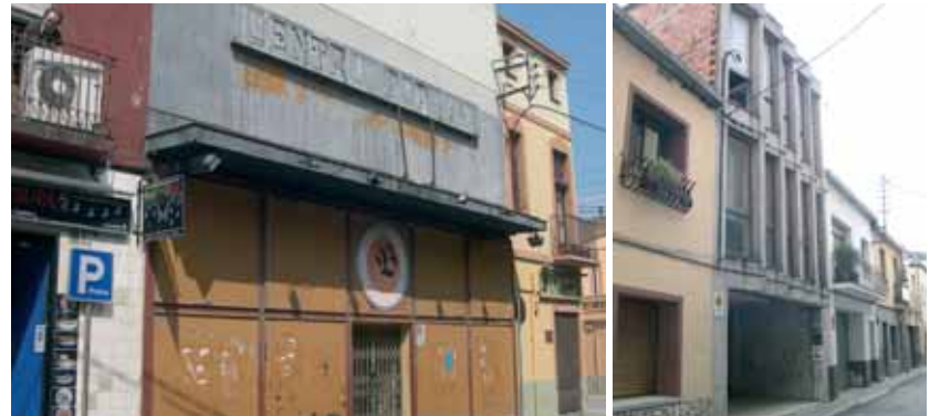
Façana de la carretera Vella i del carrer Sant Antoni respectivament
