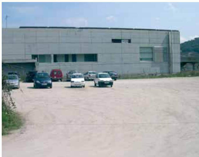
Terreny a on es construirà el pavelló
