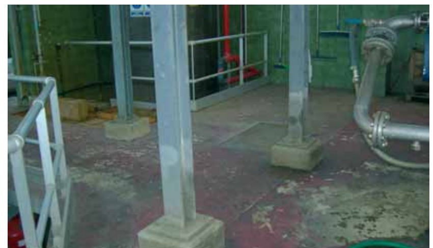
Estat actual de la sala de deshidratació
