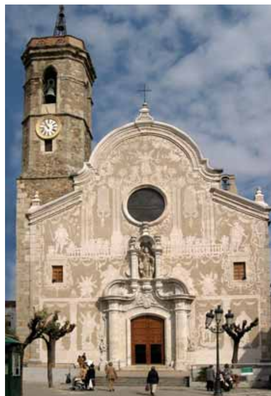
Església Parroquial. La decoració esgrafiada de la façana està considerada la més important de Catalunya
