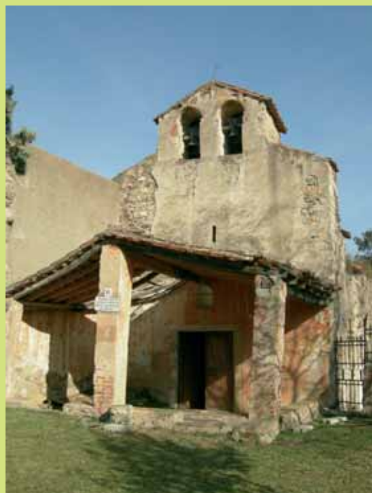
El projecte pretén restaurar les condicions de seguretat i estabilitat de l'edifici
