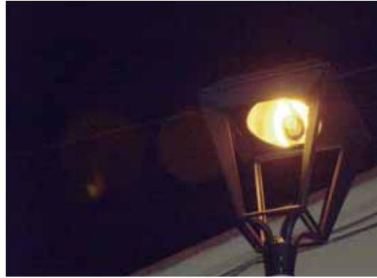
Lluminàries noves segons el nou Pla municipal d'adequació de la il·luminació exterior
