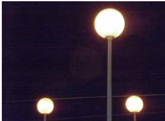
Lluminàries antigues que generaven un impacte negatiu en la foscor del cel i gastaven més energia
