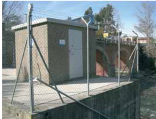
Estació d'aforament sota el pont de la Sila que controla el cabal d'aigua de la Tordera
