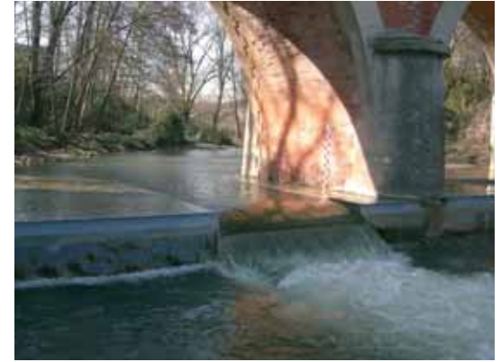
Les obres suposen una millora de la precisió de mesura de cabals superficials circulants pel riu, dada bàsica per a una bona gestió de l'aigua
