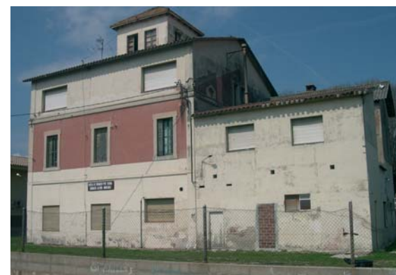
El Centre de dia es construirà on actualment hi ha l'edifici central de la Montcanut, que s'haurà d'enderrocar
