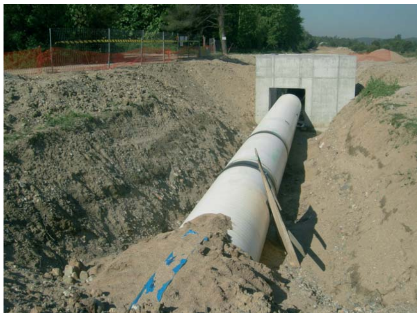
Tram de canonada i arqueta de l'artèria ATLL al seu pas per la Batllòria
