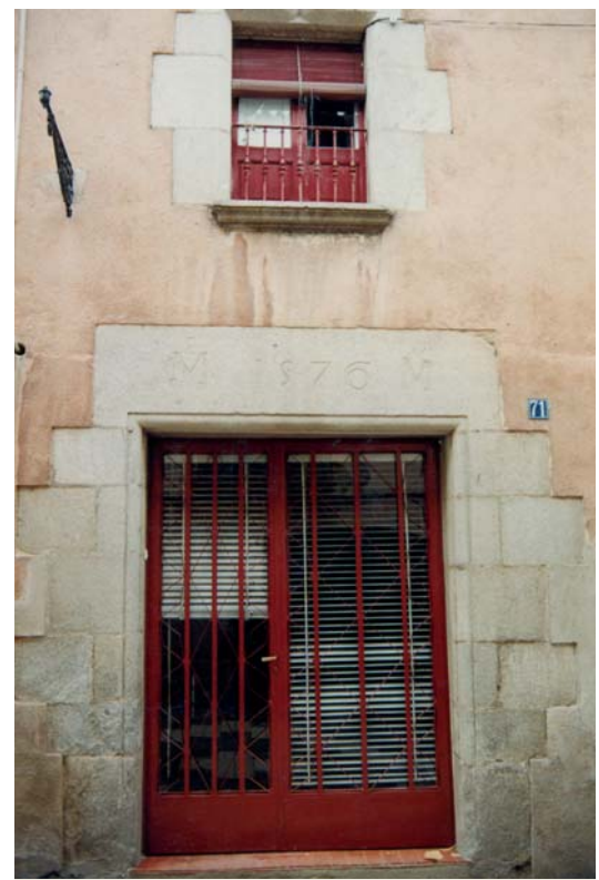
Portal de la casa Bosch, 1576
