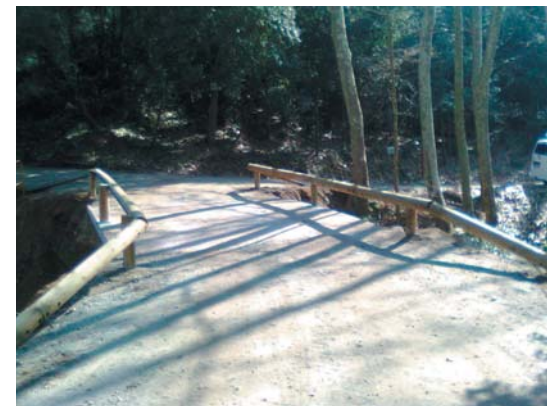
El pont s'ha adequat amb material integrat a l'entorn
