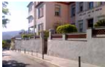
Instal·lació d'una barana a la vorera de l'avinguda Verge del Puig a l'alçada del Col·legi Cor de Maria
