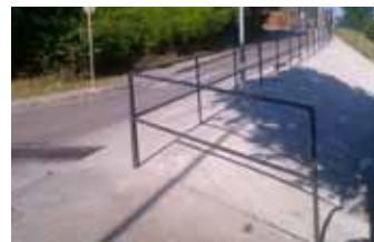
Arranjament del talús al carrer Les Torres per evitar el risc de caiguda dels vianants. S'hi ha instal·lat una tanca i s'ha projectat formigó al talús
