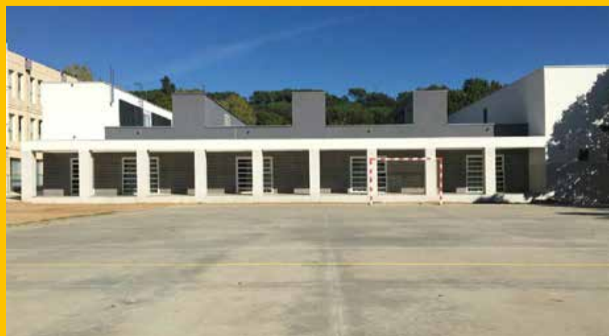
Edifici de Formació Professional de l'Institut Baix Montseny
