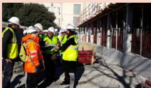
Edifici de FP de l'INS Baix Montseny que acollirà els estudis de Grau Mitjà de Manteniment i Instal·lacions i Grau Superior de Mecatrònica
