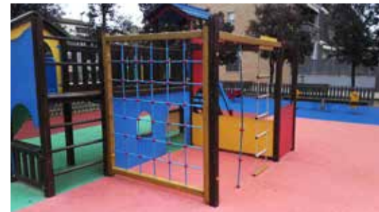
Àrea de jocs infantils al carrer Tordera En el marc dels treballs de millora i manteniment de les àrees de joc del municipi, s'ha reposat la xarxa de trepa de l'estructura que hi ha a l'àrea de jocs del carrer Tordera
