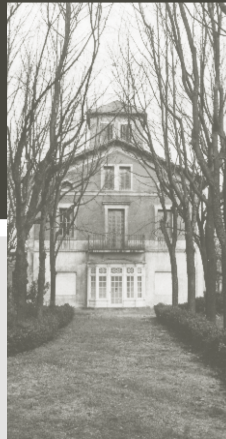
Edifici de l'Escola Moncanut
