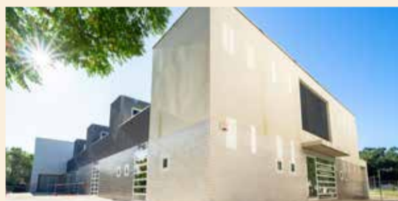
Nou edifici d'FP
