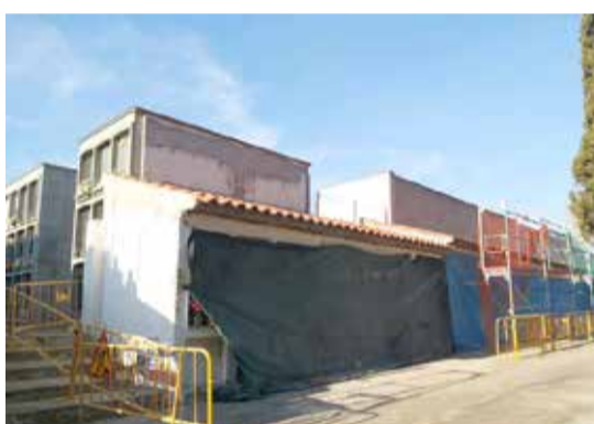
Obres de rehabilitació de les cobertes de teula i paraments al Cementiri de Sant Celoni
